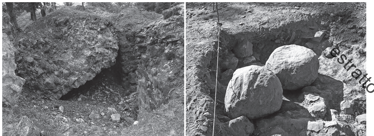
Fig. 2. Le tracce dell'assedio e della demolizione nell'area 1000: alcune delle strutture della torre "capitozzata", a sinistra, e, a destra, i proiettili lapidei rinvenuti in corso di scavo.
